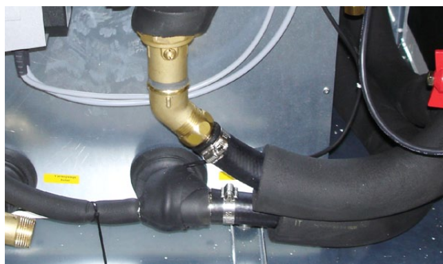
Jordslangekredsens fabriksmonterede isolering trækkes forsigtigt tilbage før montering.
