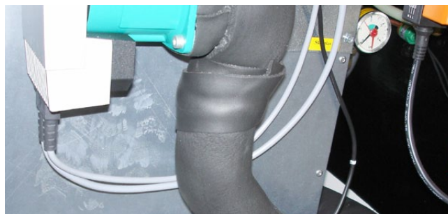
Jordslangekredsen isoleres, og samlinger tættes med isoleringstape.
