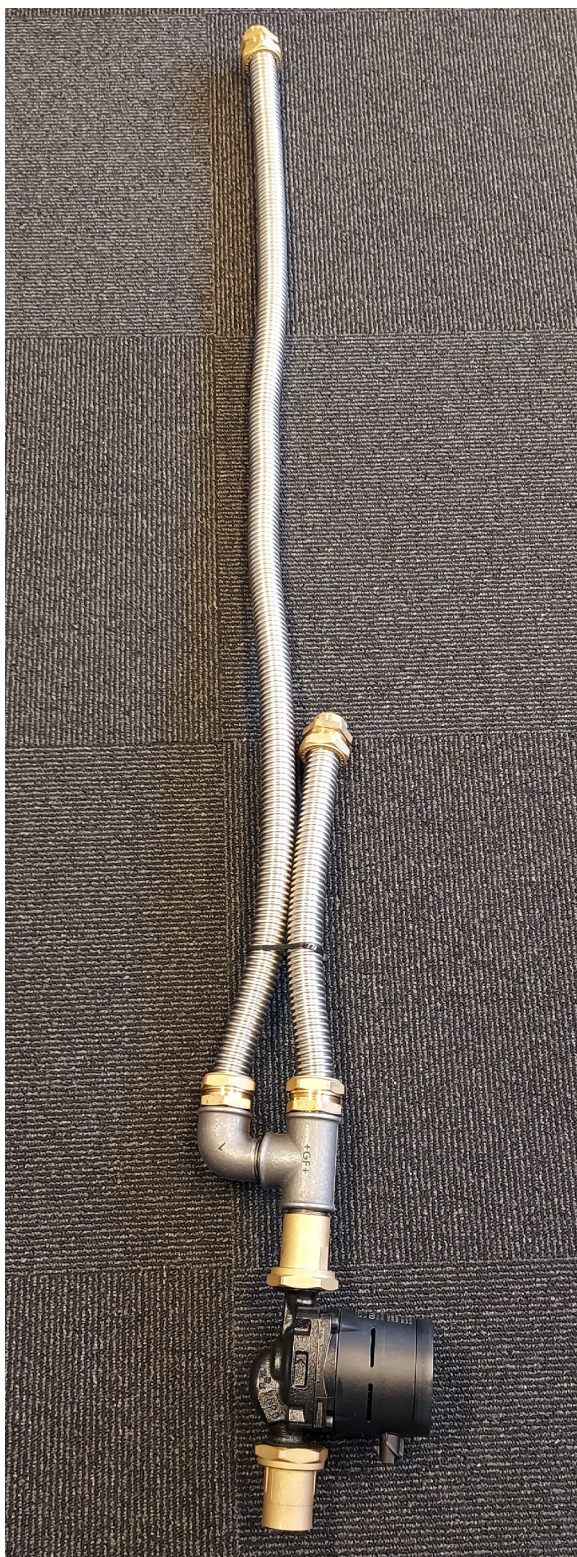
Eksempel på rørmontering til varmepumpens cirkulationspumpe
